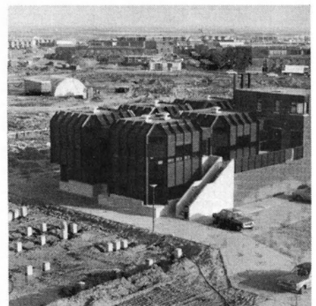
De eerste gezinnen. De werkzaamheden zijn in volle gang.
