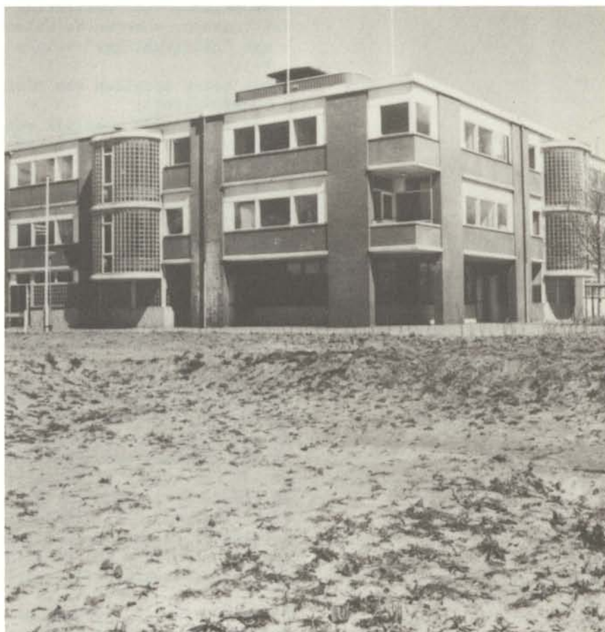
Het eerste gebouw in het centrum van Almere-Stad: Meerestein.
